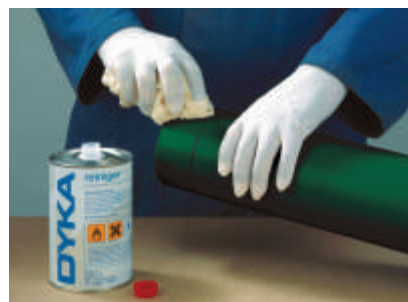
6. Curățați capătul conductei cu substanță decapantă DYKA.
