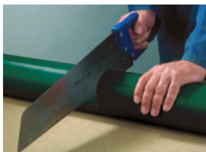
1. Tăiați perpendicular conducta
