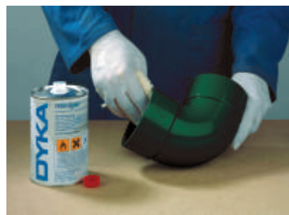
7. Curățați interiorul fittingului cu substanță decapantă DYKA.
