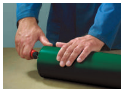
3. Debavurați muchia exterioară a conductei
