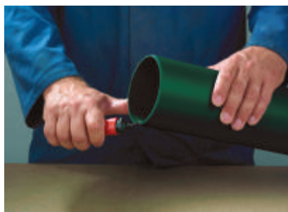
4. Debavurați muchia interioară a conductei
