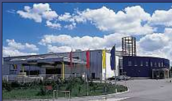
Depozitul mare, Luxemburg
