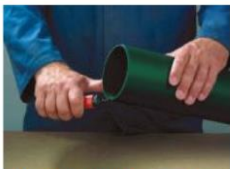
4. Debavurați muchia interioară a conductei
