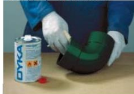
7. Curățați interiorul fittingului cu substanță decapantă DYKA
