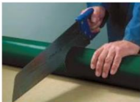
1. Tăiați perpendicular conducta
