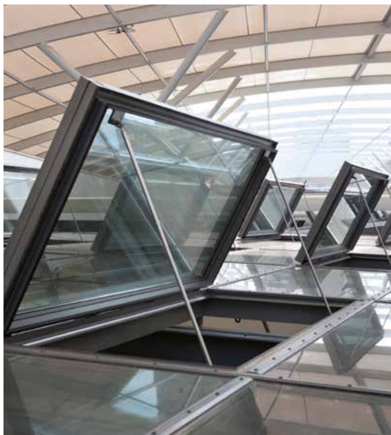
Sistem de clapete integrat în vitrajul tip Arhitectură în sticlă sistem CI
