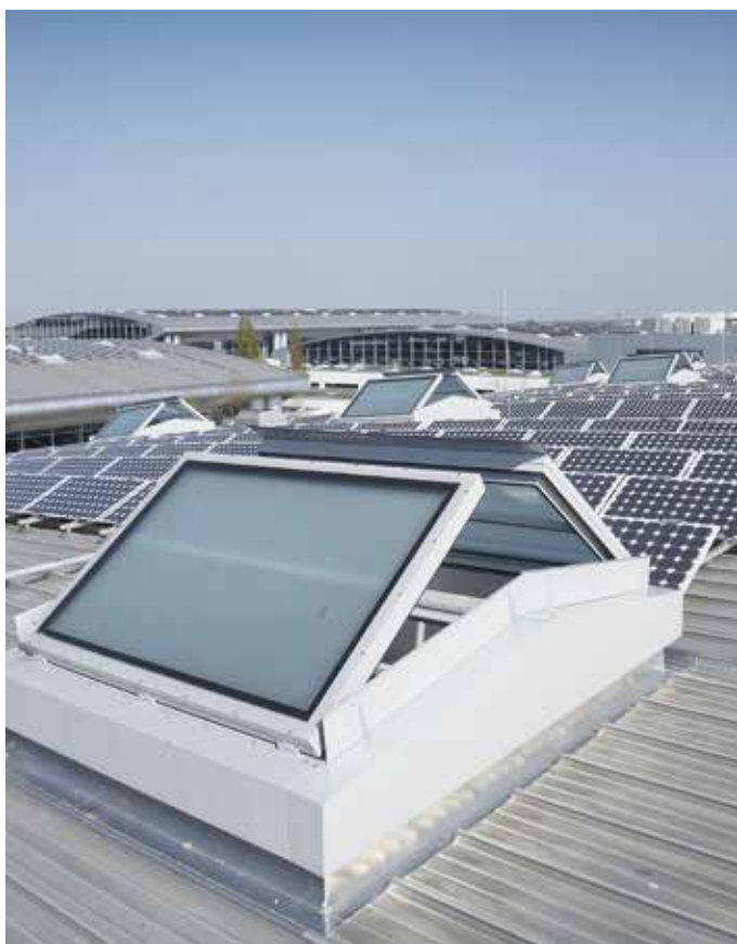
Clapetă dublă sistem CI simplu rezemată ca AFCN
